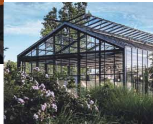
Die Hoffnungstaler Stiftung Lobetal will in Wandlitz – in der Kirchstraße 12 – ein Projekt zum Inklusiven Wohnen realisieren. Außerdem sollen auch Möglichkeiten zum Arbeiten geschaffen werden. Möglich wäre, beispielsweise die Reithalle um ein Gewächshaus zu erweitern.
