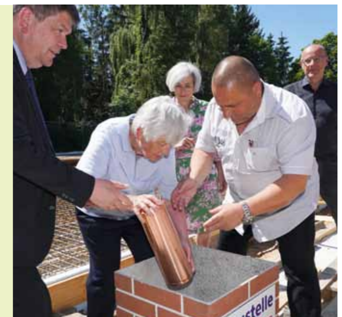
Christa Stiller legt die Grundsteinrolle in das Fundament. Sie wird später eine der Wohnungen beziehen. Martin Wulff, Geschäftsführer (li.) und Frank Kulicke, Bürgermeister von Werneuchen sind an ihrer Seite.
